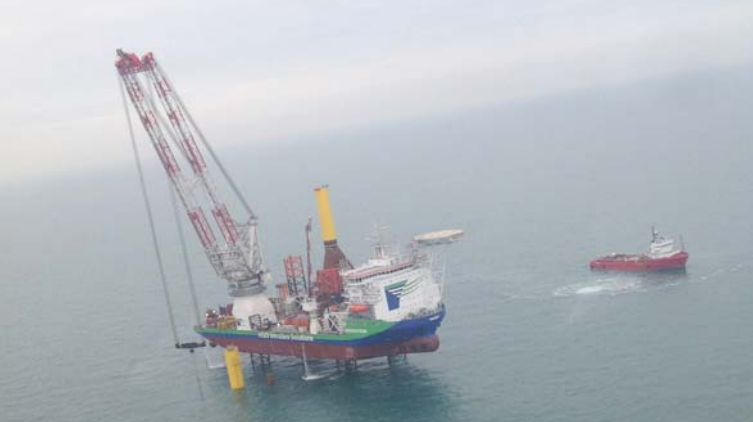
HOCHTIEF – Die „INNOVATION“ hat mit der Errichtung begonnen
